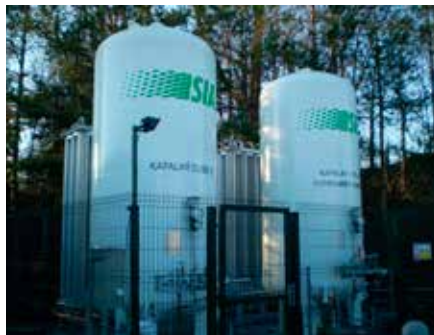
Zásobníky na LOX (VRV 5000/18) a LIN (VRV 5000/37) se dvěma odpařovači SG70HF
