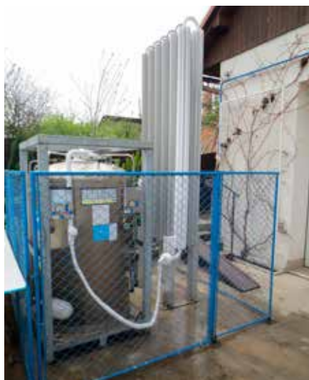
Instalace kontejneru na zkvapalněný kyslík s odpařovačem
